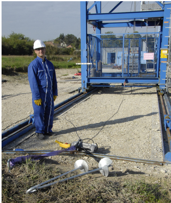
Gerüst auf Schienen wird gezogen
